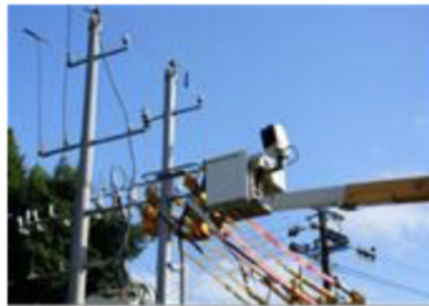
图 1 配网检修现场
