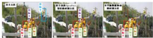
图2 配网检修不停电作业现场运动目标识别结果
