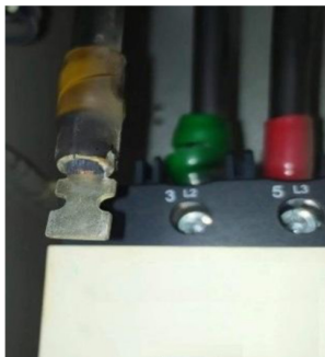
图 3 接线端子和导线发黑情况
