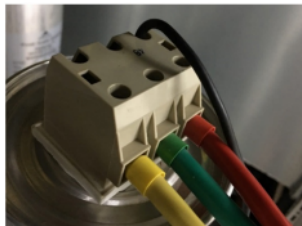
图 4 电缆铜芯线头固定方式
